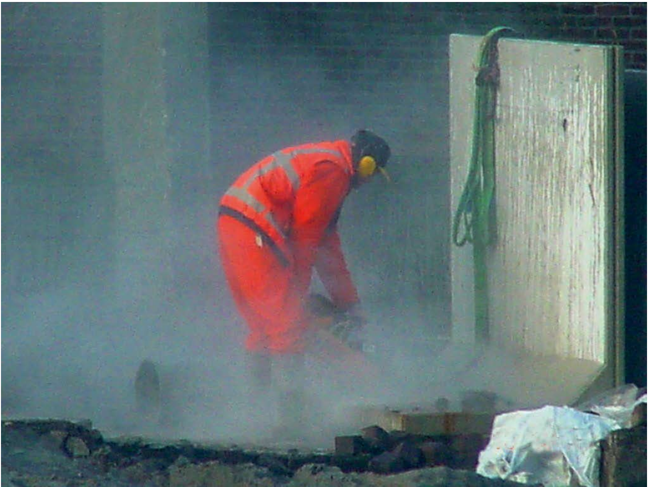
Doorslijpen bouwmetaal
